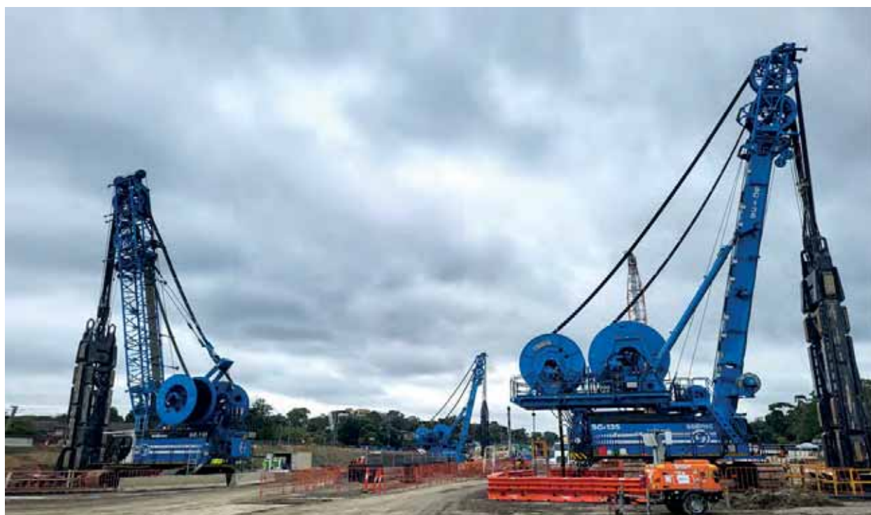
3 esemplari di idrofresa Soilmec modello SC-135 "Tiger" nel cantiere North East Link | Melbourne, Australia
